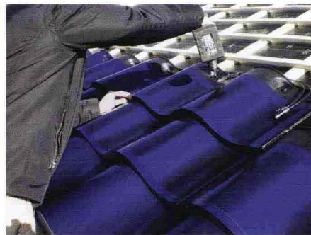
Tegole fotovoltaiche solari, ideali anche per stabili d'epoca, in grado di generare 860 Kwh per 100 mq all'anno
